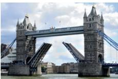
*Originalmente, el mecanismo de elevación del puente funcionaba a vapor. Hoy funciona con aceite y electricidad.*
