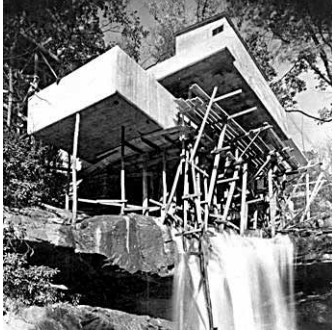
Baugerüst (©F.L.Wright Fdn.)
